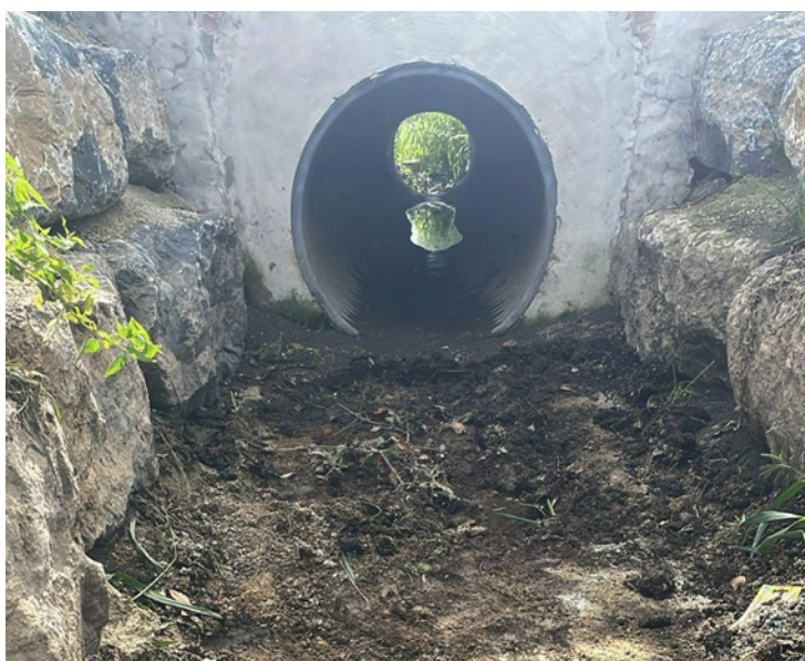
Curage du passage sous la voie de chemin de fer à Gastuche
