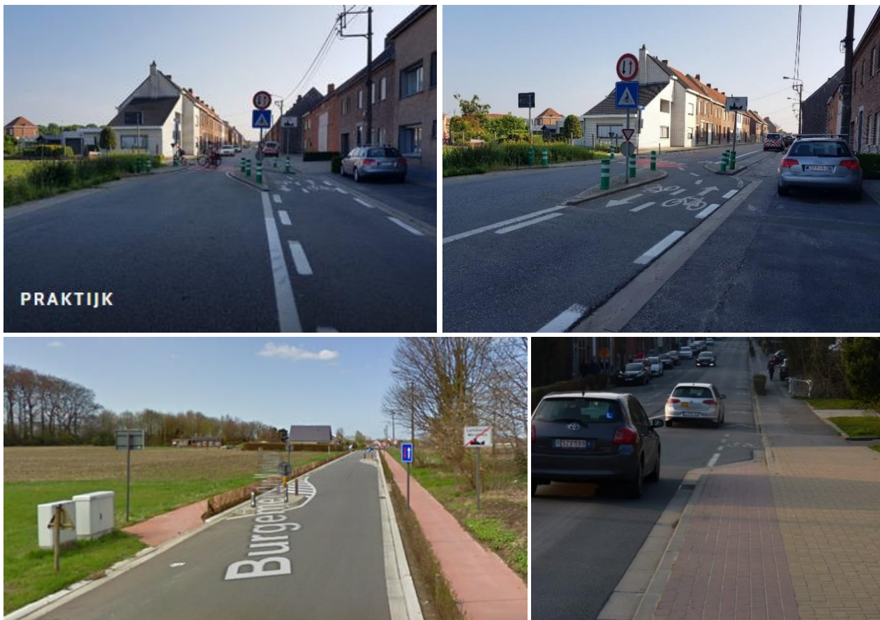
Figure 36 : Exemples d'aménagements assurant la bonne insertion de cyclistes à Hulste (en haut), à Merelbeke (en bas, à gauche) et à Gembloux (en bas, à droite). Source exemple de Hulste: https://fietsberaad.be/themas/fietsinfrastructuur/fiets-rugdekking/
