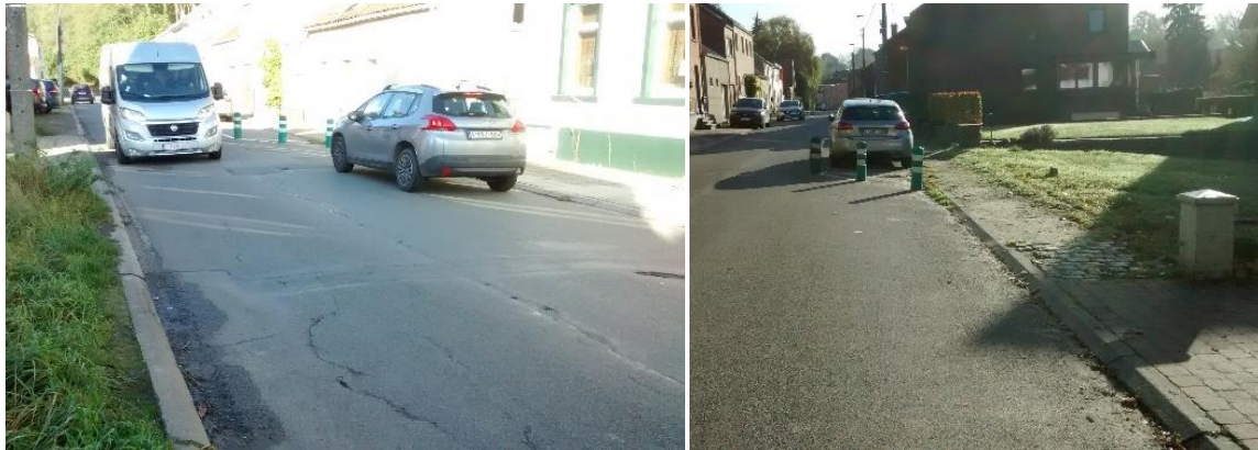
Figure 10: Des chicanes présentes sur la plupart des routes de transit dans la commune peuvent créer des situations dangereuses pour les cyclistes (ici Rue de Hamme-Mille à Nethen).
