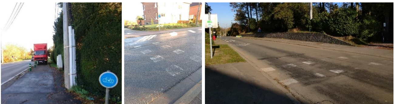
Figure 13: Stationnement d'un camion sur la piste cyclable (à gauche). Marquage peu visible pour certaines traversées et manque de dispositifs sécurisant (à droite).
