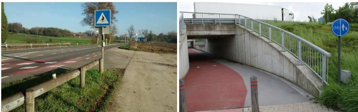
Figure 41 : Traversée de la N25 dangereuse entre centre sportif et Rue Philippe Collette (gauche) et solution sécurisante sous voie (Sécurothèque - dimensionnement des aménagements cyclables).
