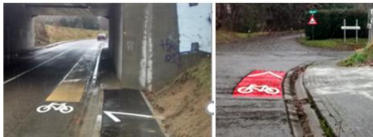
Figure 30 : Dispositif cyclable ne garantissant pas suffisamment de sécurité au cycliste.
