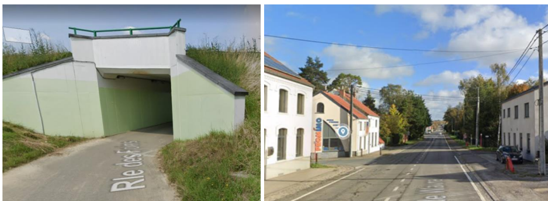
Figure 42 : Passage sous N25-Ruelle des Foins (gauche) et carrefour N268-Ruelle des Foins à sécuriser.
