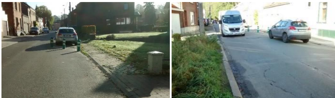
Figure 37 : Chicanes/dévoiements à Nethen.
