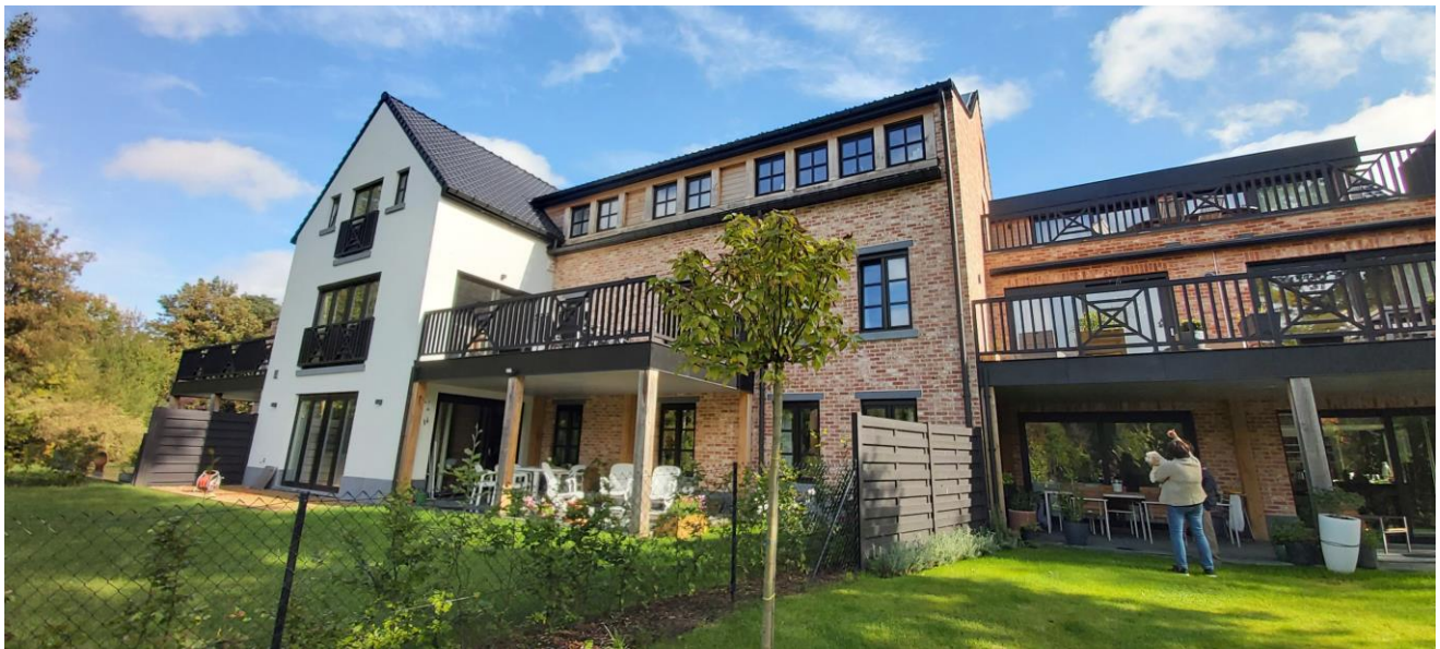
Photo n°7 : Bâtiment A (façade arrière)
