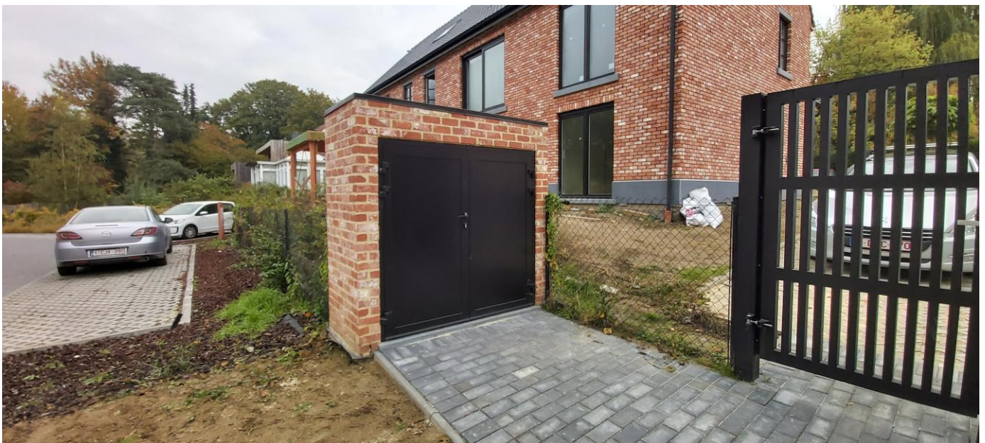
Photo n°15 : Edicule pour régies près du bâtiment B
