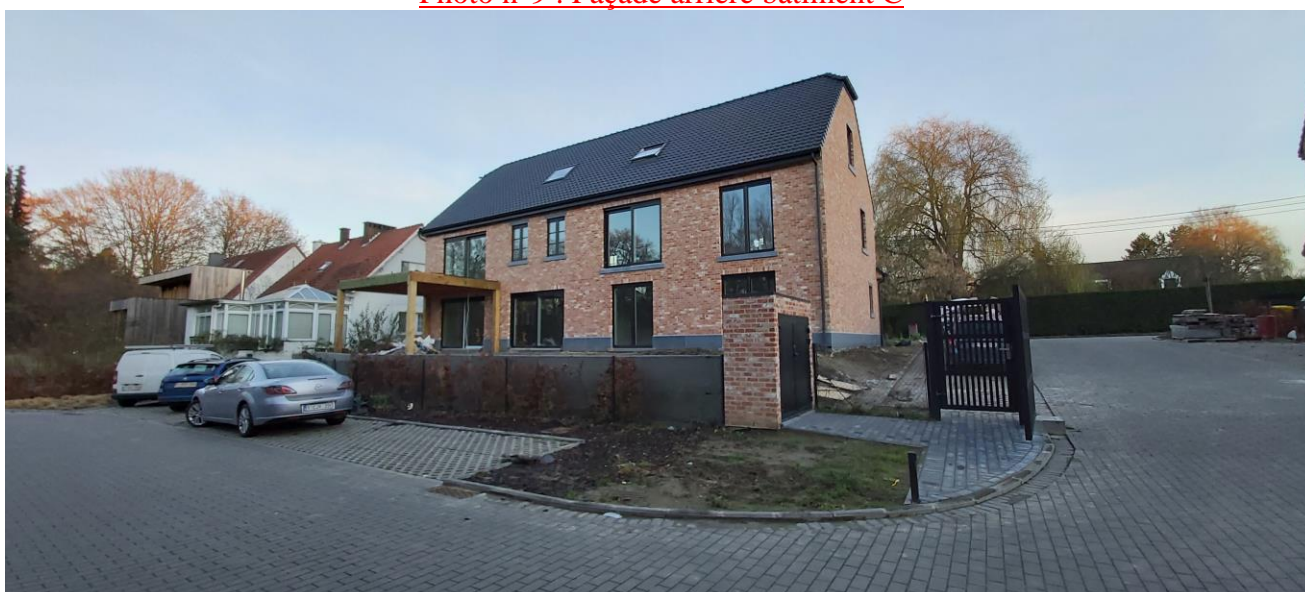
Photo n°10 : Façade arrière bâtiment B
