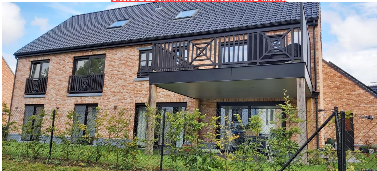
Photo n°9 : Façade arrière bâtiment C
