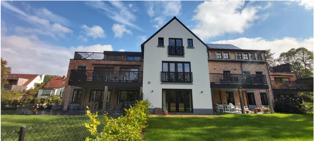
Photo n°6 : Bâtiment A (façade arrière)
