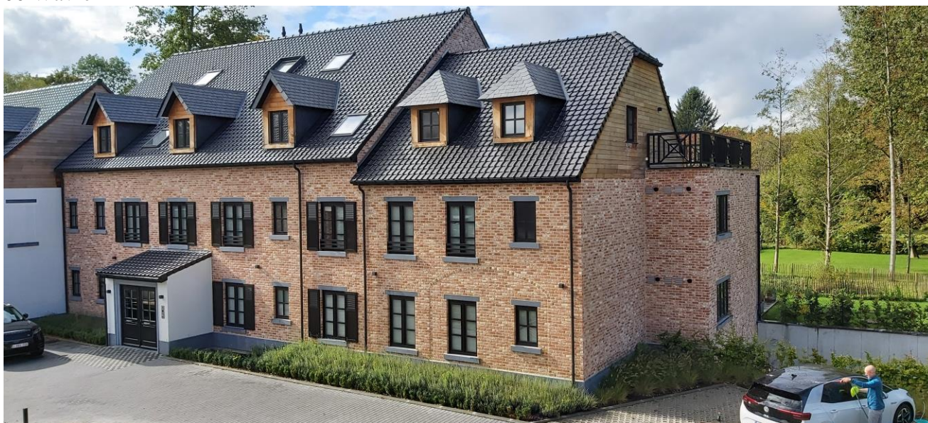
Photo n°11 : Façade avant bâtiment A
