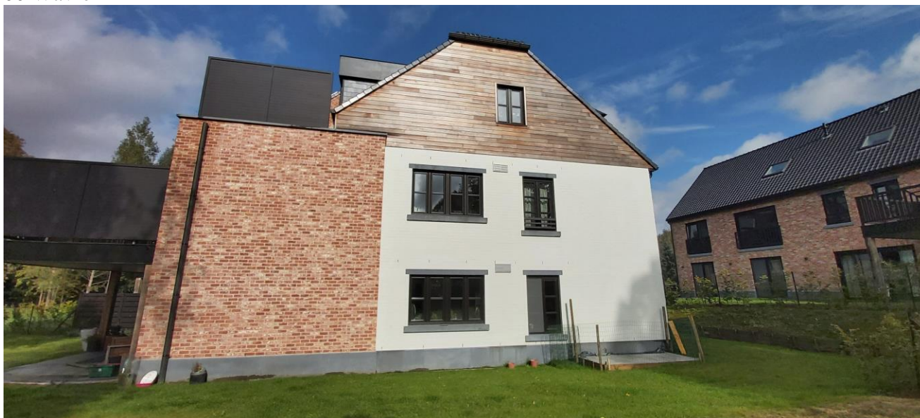
Photo n°8 : Bâtiment A (façade latérale gauche)
