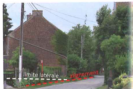
Maison implantée à la fois sur une limite latérale avec un coin sur l'alignement.
