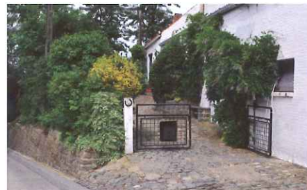
Une maison avec rampe d'accès surplombant la voirie.
