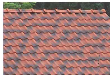
A éviter : les tuiles artificiellement panachées.
