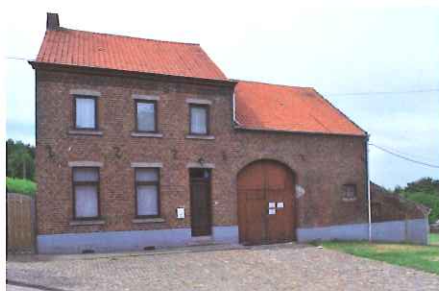
Un accès de plain-pied avec la voirie.
